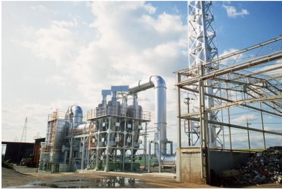
高温多湿ガスに於いては5 $\mu$ 以上の粉塵・煤塵の保障捕集効率を97w%以上で実施しております。稼動状況は実捕集効率:99.7w%以上です。例えば、過熱水蒸気中の無機物・有機物が混在した、個々の比重に大きな差がある下水乾燥污泥微粉の回収に於いても、入口濃度2g/Nm<sup>3</sup>に対して排ガス濃度が約0.004g/Nm<sup>3</sup>と言う高効率を発揮しております。電気ヒーター式の昇温装置を取り付けて、結露も無く、長時間の連続運転に対応しております。
